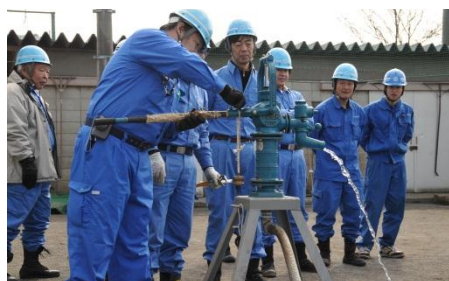
三鷹市管工事業協同組合の皆さんによる 災害時飲料水給水所設置訓練
